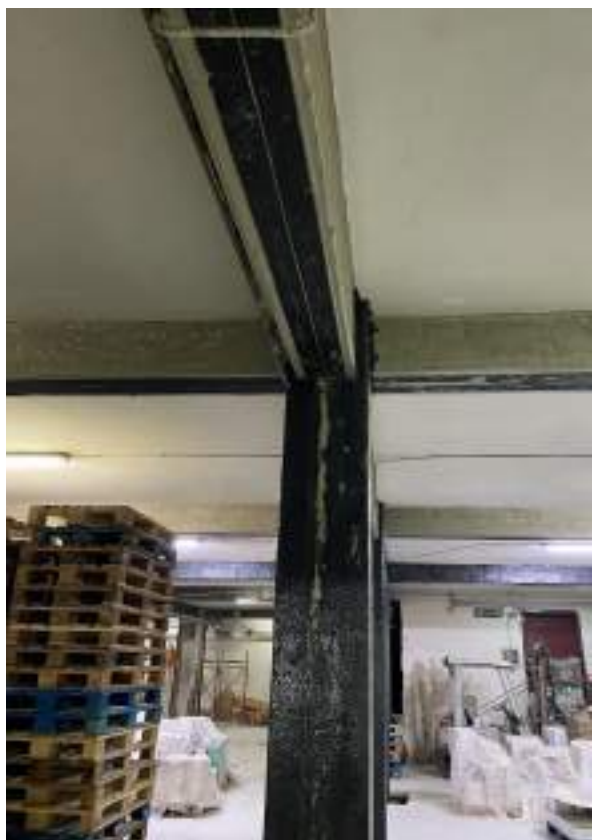
Immagine 7: Rinforzo travi in c.a. o c.a.p. con lamelle pultruse CFK.
