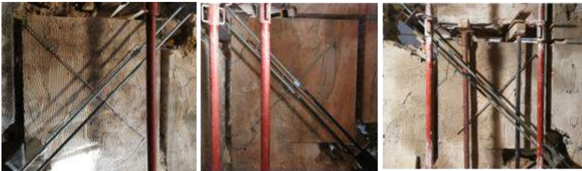
Figura 84: Prove di compressione diagonale eseguite in situ sui 3 pannelli in muratura.
