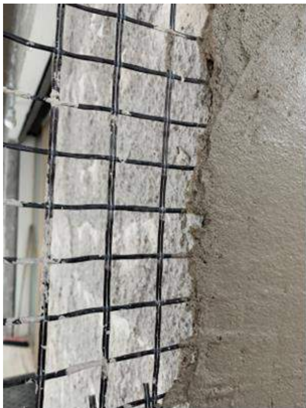
Immagine 36: Applicazione sistema FRM.
