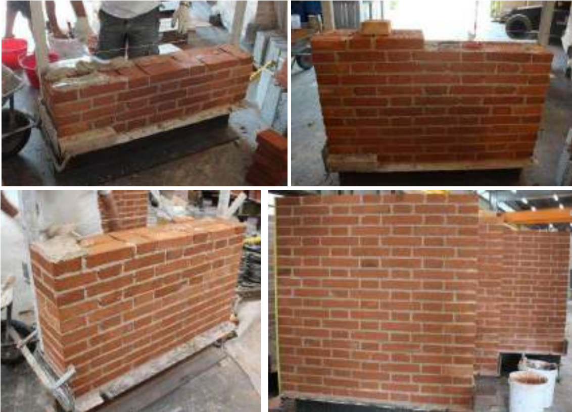
Figura 86: Realizzazione dei pannelli murari.
