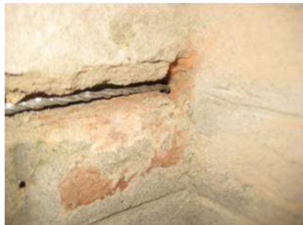
Immagine 56: Applicazione ristilatura armata (SAC).
