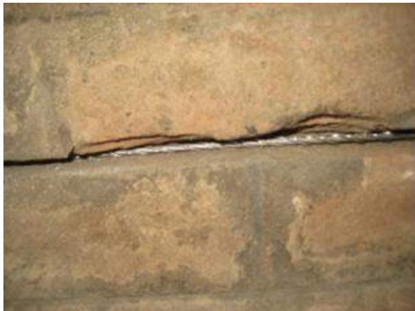
Immagine 56: Applicazione ristilatura armata (SAC).
