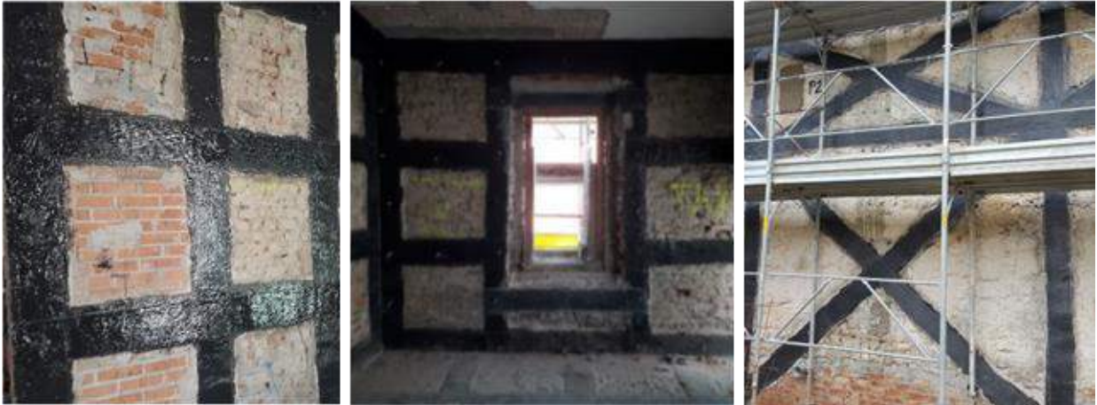
Immagine 28: Applicazione tessuti CFRP su muratura portante.
