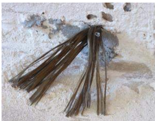
Immagine 37: Inghisaggio e sfioccatura connettore.
