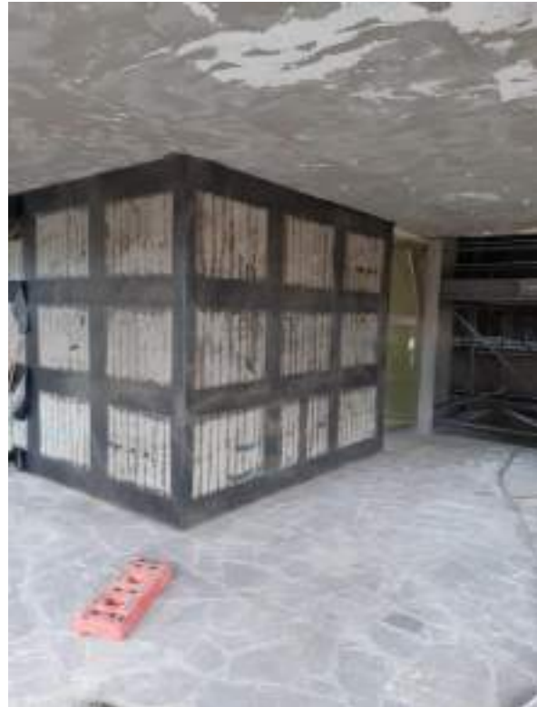
Immagine 11: Realizzazione rinforzo su setti in c.a. con CFRP.
