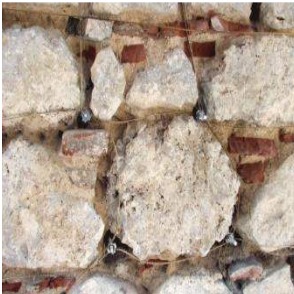
Immagine 54: Sistema ANCHORSTEEL NET su laterizio regolare e pietrame squadrato.
