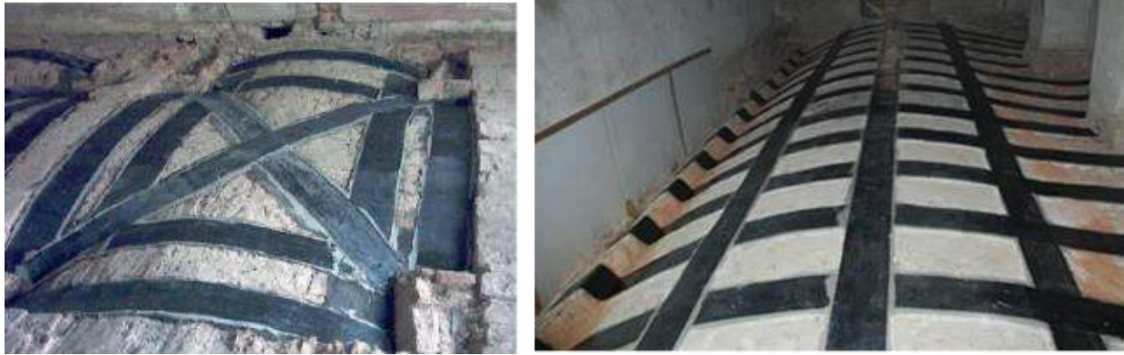
Immagine 31: Applicazione CFRP System su archi/volte in muratura.
