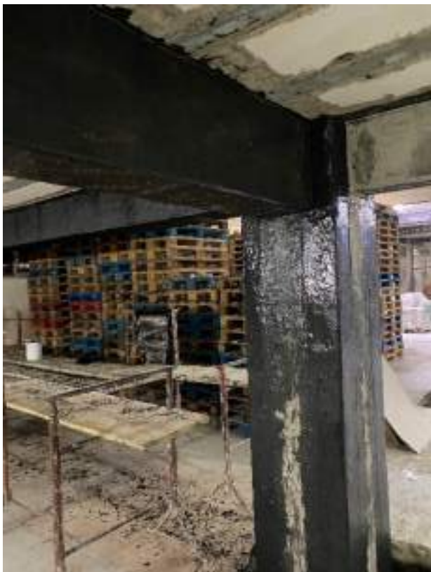
Immagine 6: Rinforzo travi in c.a. o c.a.p. con tessuti CFRP.
