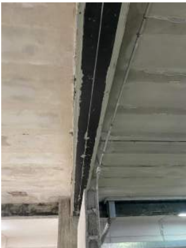
Immagine 7: Rinforzo travi in c.a. o c.a.p. con lamelle pultruse CFK.
