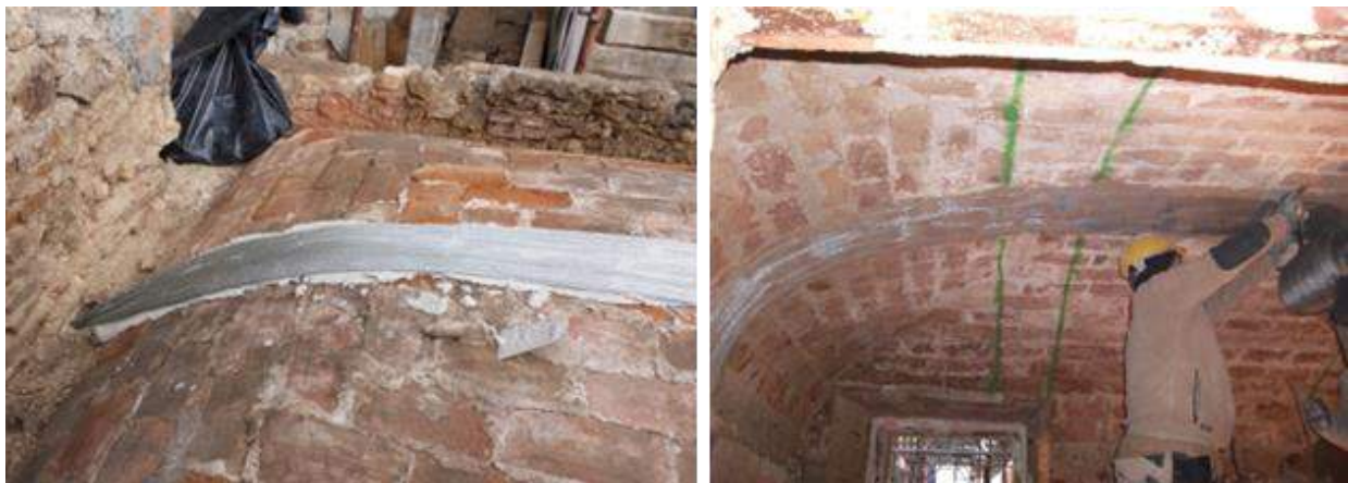
Immagine 46: Applicazione SRG System su volte in muratura.
