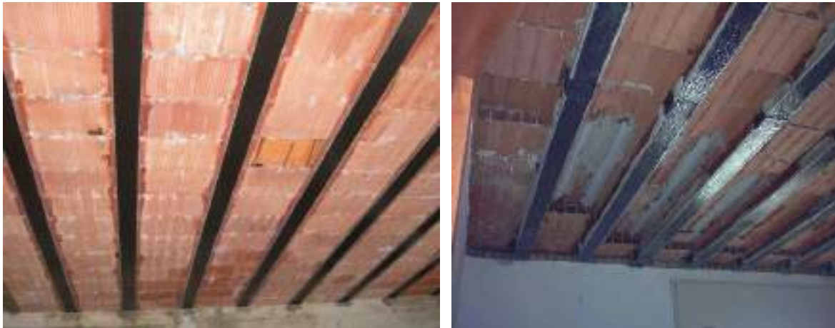
Immagine 13: Applicazione tessuti CFRP su travetti solaio in latero-cemento.
