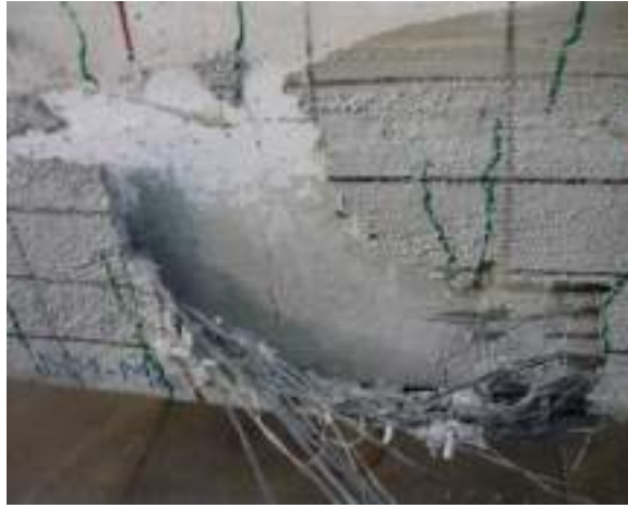
Figura 77: Dettaglio delle fibre di carbonio dopo la rimozione della malta.
