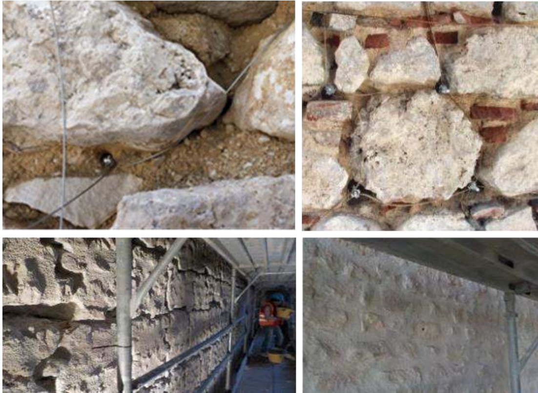
Immagine 69: Applicazione ANCHORSTEEL NET.
