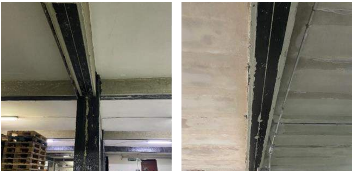
Immagine 61: Applicazione lamelle in CFRP.
