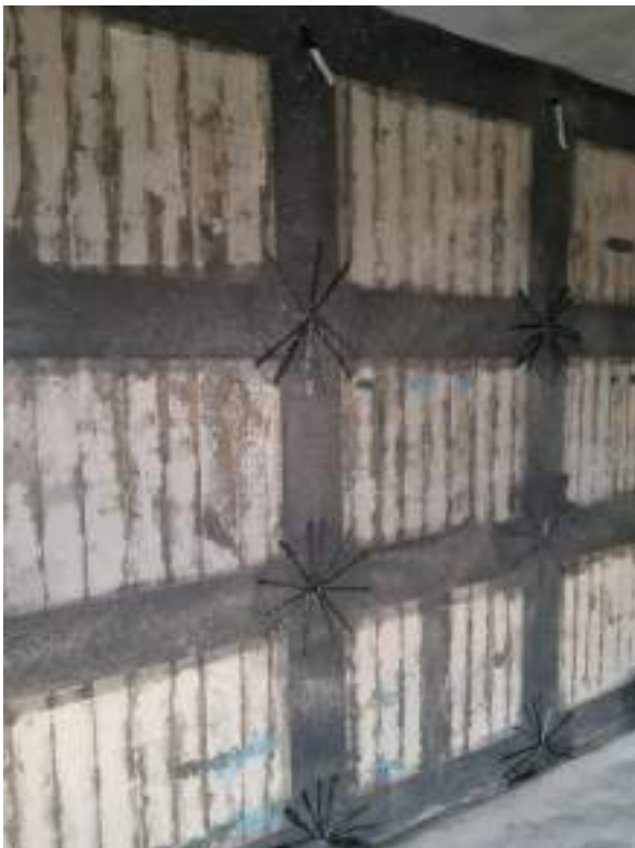
Immagine 11: Realizzazione rinforzo su setti in c.a. con CFRP.
