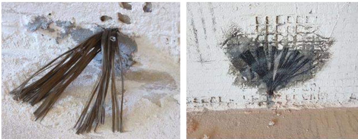
Immagine 65: Inghisaggio e sfiocatura del connettore.
