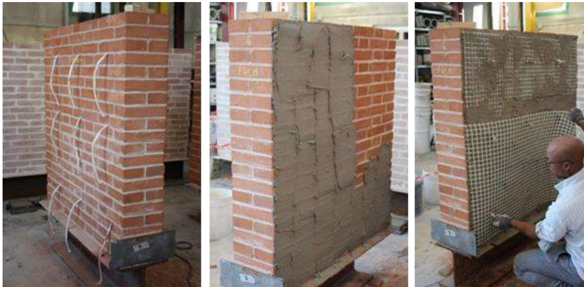
Figura 89: Fasi di applicazione del rinforzo per il pannello CD_4, lato A e lato B.
