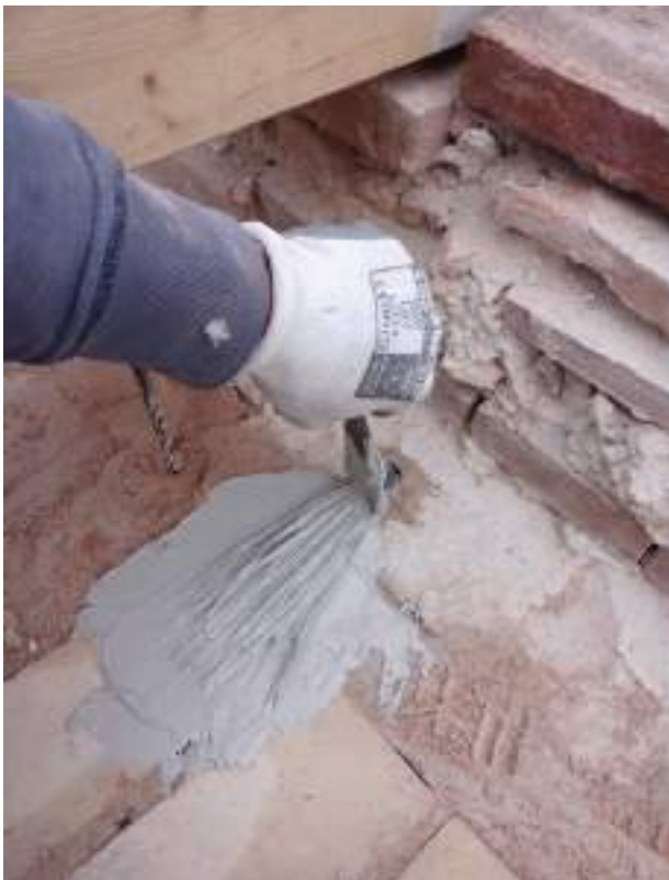
Immagine 43: Applicazione SRG System su cordolo esistente in muratura portante.
