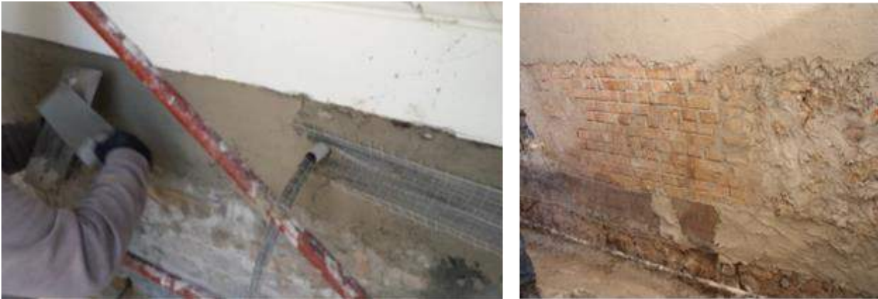
Immagine 39: Applicazione con SRG system su murature.
