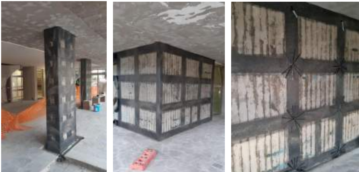
Immagine 57: Applicazione CFRP System.
