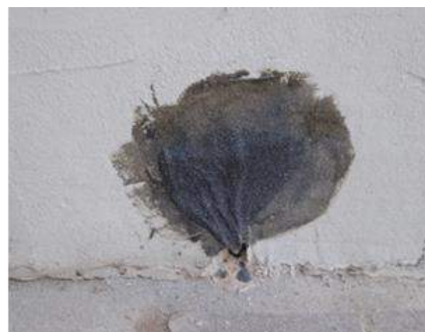
Immagine 37: Inghisaggio e sfioccatura connettore.
