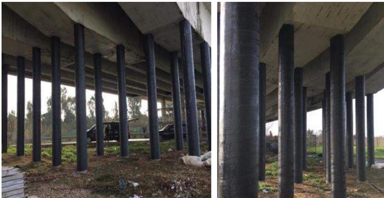
Immagine 63: Impiego di tessuti CFRP sul viadotto della Scafa a Roma.
