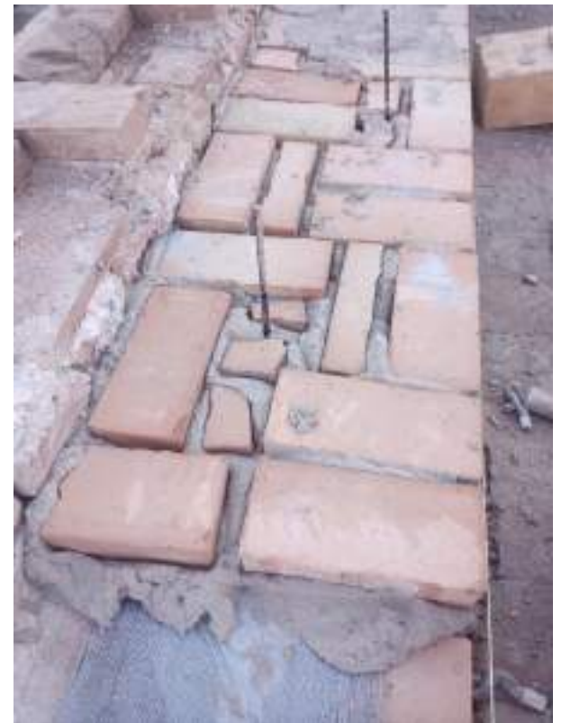
Immagine 43: Applicazione SRG System su cordolo esistente in muratura portante.
