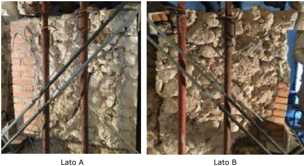
Figura 81: Configurazione fessurata del pannello non rinforzato N°1 al termine della prova di compressione diagonale.
