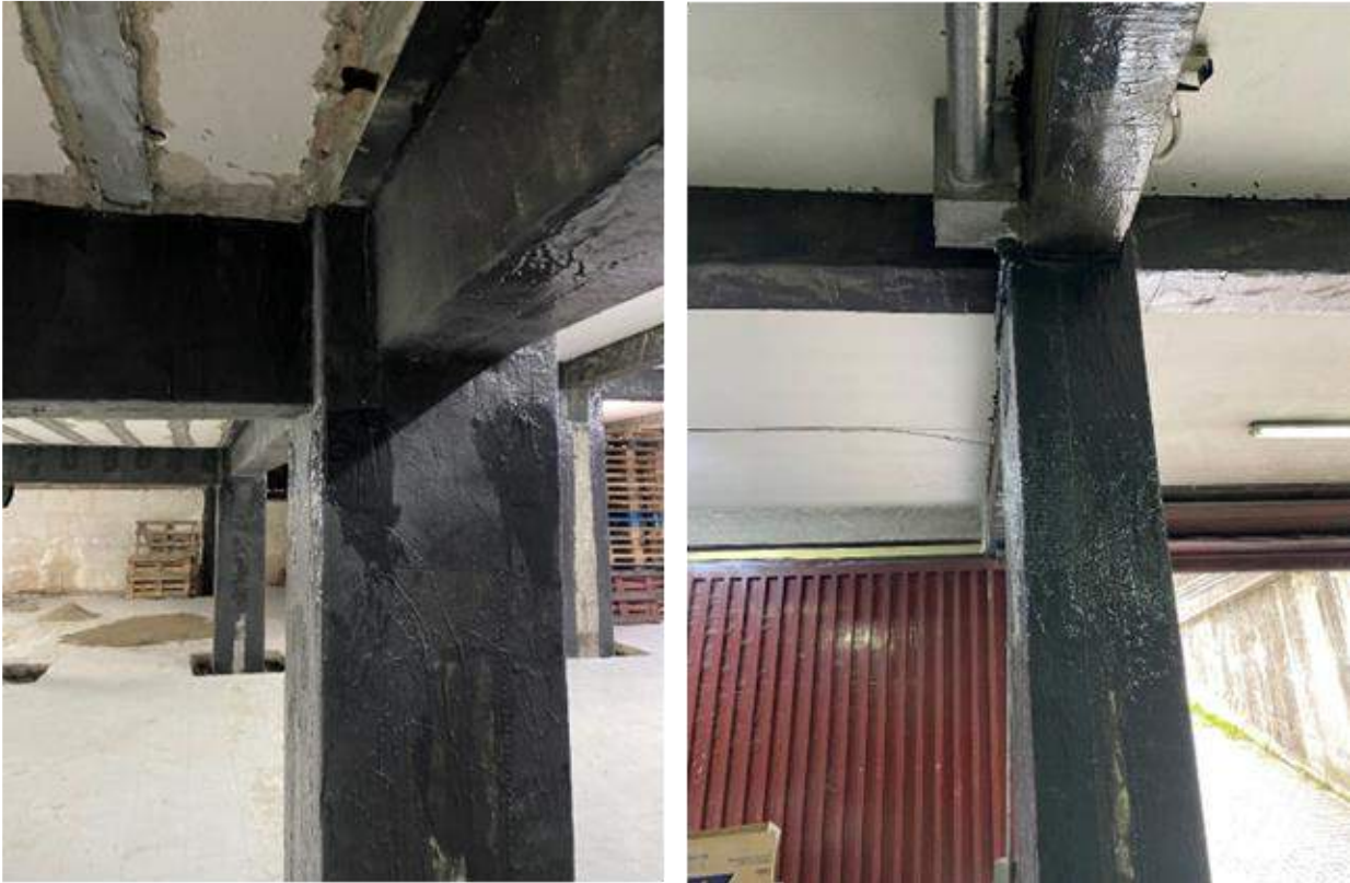
Immagine 60: Applicazione tessuti in CFRP.
