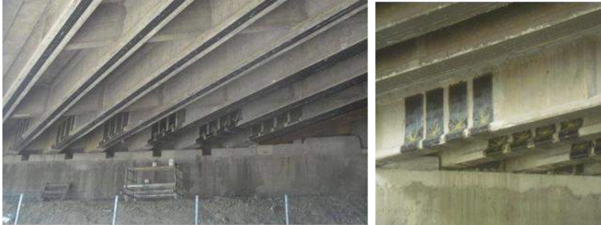
Immagine 62: Applicazione CFRP System.
