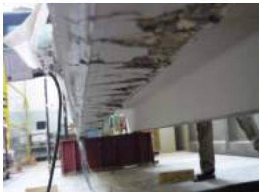
Figura 76: Dettaglio della trave rinforzata con lamine in CFRP a prova conclusa.
