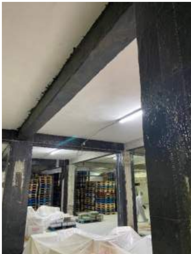
Immagine 6: Rinforzo travi in c.a. o c.a.p. con tessuti CFRP.
