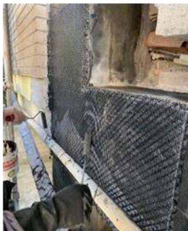
Immagine 8: Rinforzo nodo di parete con CFRP.
