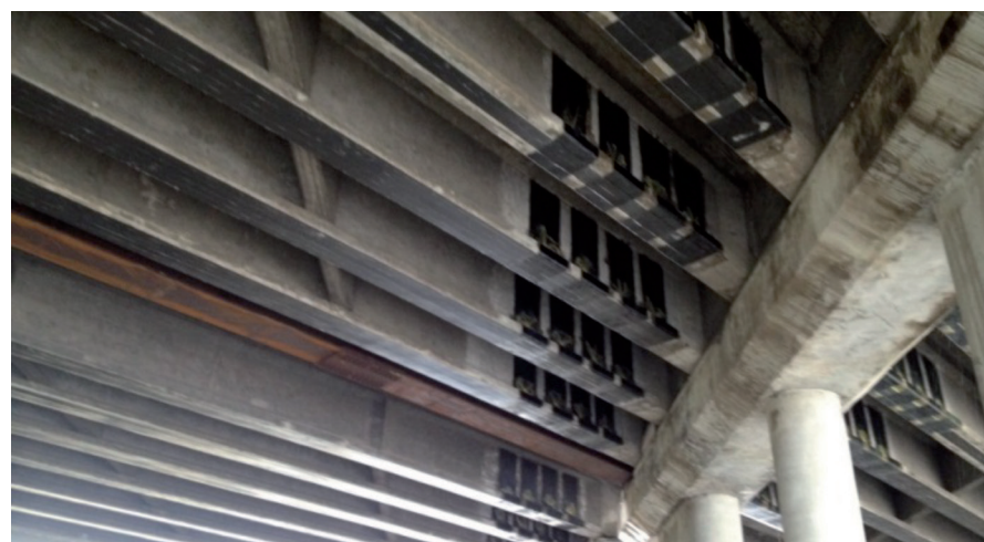
Figura 1 - Schema di disposizione del rinforzo CFRP
