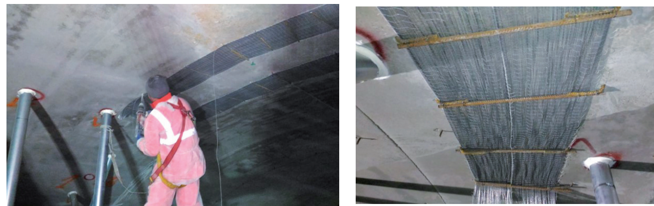
Figure 6 - Fasi operative di applicazione del rinforzo
