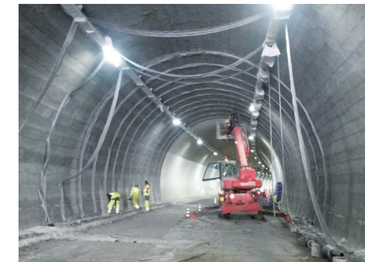
Figura 4 - Applicazione del rinforzo SRG all'intradosso della galleria
