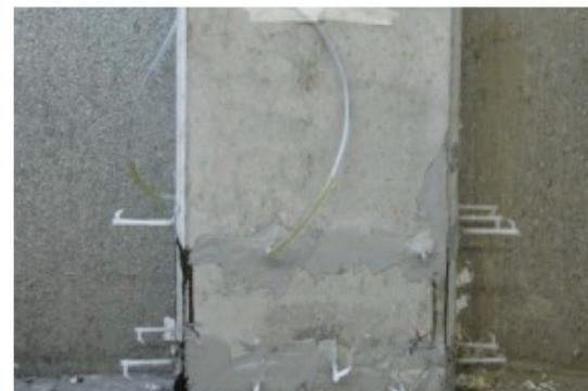
**FASE 5:** Ricostruzione delle sezioni e delle parti ammalorate con malte cementizie monocomponenti o bicomponenti CONCRETE ROCK V o CONCRETE ROCK V2.
