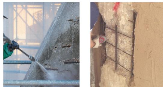
**FASE 3:** Applicazione di passivante protettivo bicomponente FERROSAN sui ferri d'armatura. Nella fase di preparazione del prodotto, aggiungere la polvere al liquido, senza aggiunta di acqua, mescolando accuratamente con agitatore meccanico per ca. 3 min al fine di ottenere una boiaccia fluida e priva di grumi. Stendere il prodotto a mezzo pennello in due mani entro ca. 30 min. dalla pulizia del ferro d'armatura. Attendere circa 60 min. tra una mano e l'altra e non più di 24 ore.
