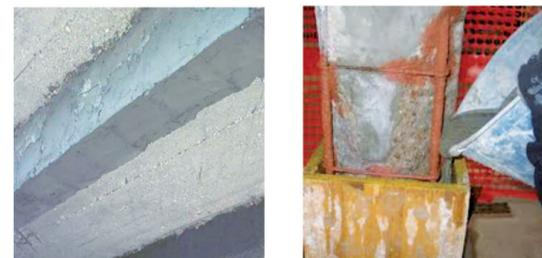
**FASE 6:** Protezione anticarbonatante del calcestruzzo mediante rasatura con rasante polimerico bicomponente RASEDIL AS e vernice metacrilica RESINCOLOR o vernice poliuretanica ad elevata elasticità RESINLAST S.
