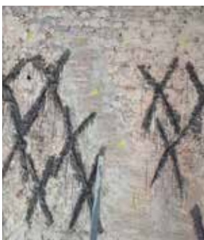
Cantiere Palazzo Signorini-Corsi (AQ). Connettori passanti AFIX con adesivo Resin 75.
