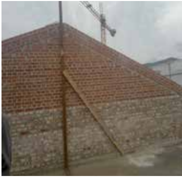
Cantiere di Roio Poggio e Roio al Piano (AQ) Rinforzo di volte e murature con rete in fibra di vetro AR G-NET 301 BAL, connettori in vetro GFIX AR e matrice inorganica.
