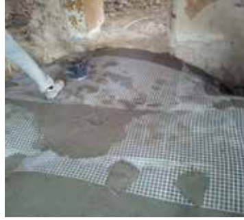
Cantiere di Roio Poggio e Roio al Piano (AQ) Rinforzo di volte e murature con rete in fibra di vetro AR G-NET 301 BAL, connettori in vetro GFIX AR e matrice inorganica.
