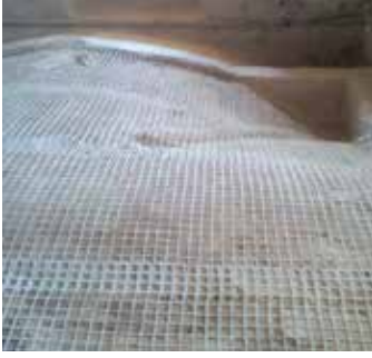
Cantiere di Roio Poggio e Roio al Piano (AQ) Rinforzo di volte e murature con rete in fibra di vetro AR G-NET 301 BAL, connettori in vetro GFIX AR e matrice inorganica.
