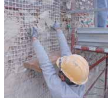
Cantiere di Roio Poggio e Roio al Piano (AQ) Rinforzo di volte e murature con rete in fibra di vetro AR G-NET 301 BAL, connettori in vetro GFIX AR e matrice inorganica.
