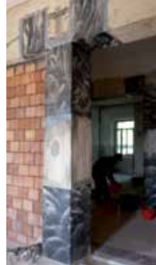
Cantiere Istituto Apostole S. Cuore di Gesù, Avezzano (AQ). Rinforzo di murature, setti, pilastri con rete in fibra di carbonio C-NET, connettori in aramide AFIX e malta CONCRETE ROCK S.
