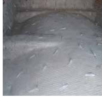
Cantiere di Roio Poggio e Roio al Piano (AQ) Rinforzo di volte e murature con rete in fibra di vetro AR G-NET 301 BAL, connettori in vetro GFIX AR e matrice inorganica.
