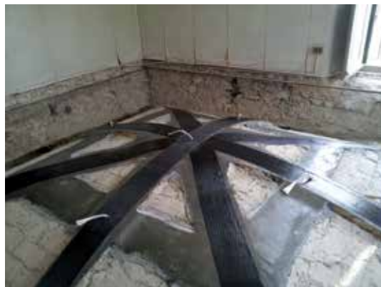
Rinforzo volte in muratura con fibra di carbonio C-Sheet e connettori GFIX in vetro Castel di Ieri (Aq) - Aggregato privato
