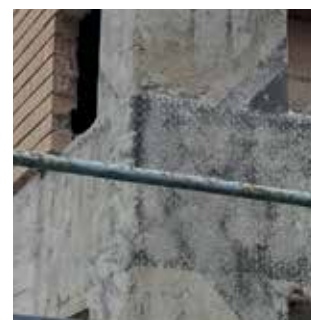
Rinforzo nodi e pilastri c.a. con fibra di carbonio bidirezionale CTB e quadriassiale C-Sheet L'Aquila - Condomini
