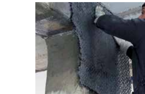
Rinforzo pilastri e nodi c.a. con fibra di carbonio quadriassiale C-Sheet Gignano (Aq) - Edificio privato
