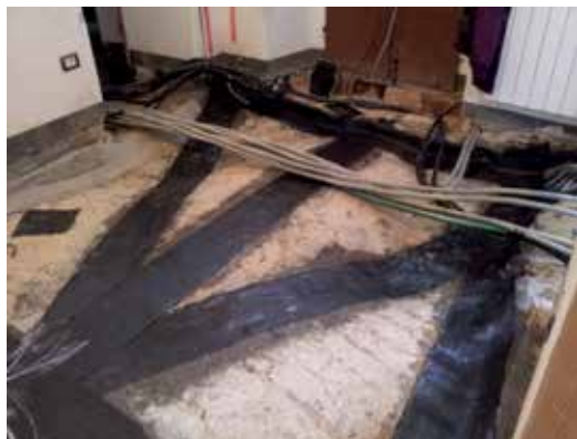
Cermignano (Te) Loc. Poggio delle Rose - Edificio privato
