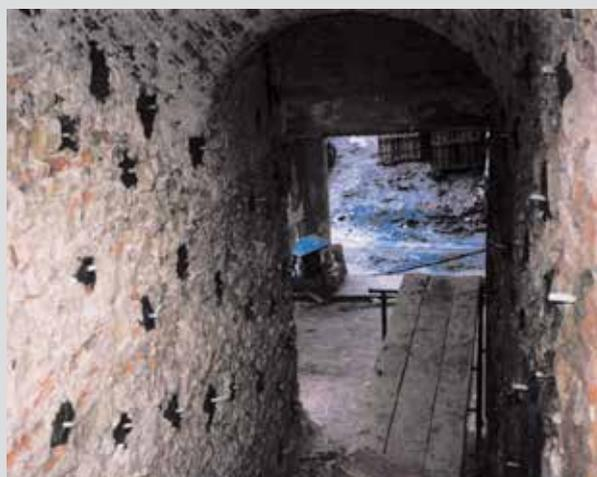
Iniezioni di boiacche in calce idraulica NHL 5,0 in murature antiche.
