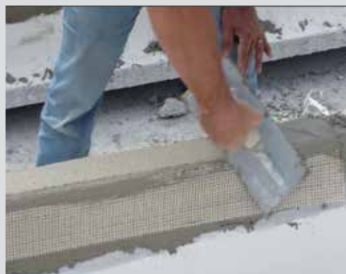
Fig. 2 applicazione della malta Concrete Rock V2 e del tessuto in acciaio STEEL NET 190 su supporto in cls.
