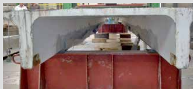
Fig. 6 Test a rottura trave in c.a.p. rinforzata.
