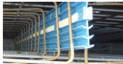
Particolare WATERGUARD BREAK posizione 2)
