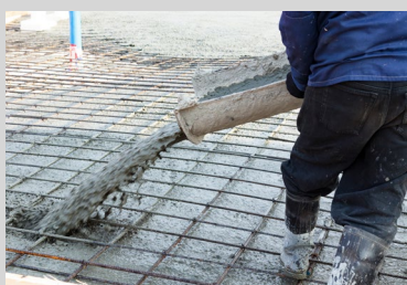
Getto di calcestruzzo impermeabile con additivo cristallizzante
