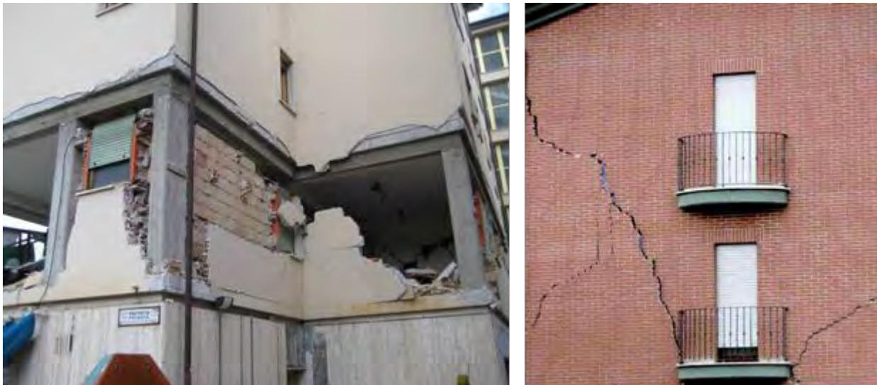
*Immagine 18: Pareti di tamponamento danneggiate in seguito a un sisma.*
