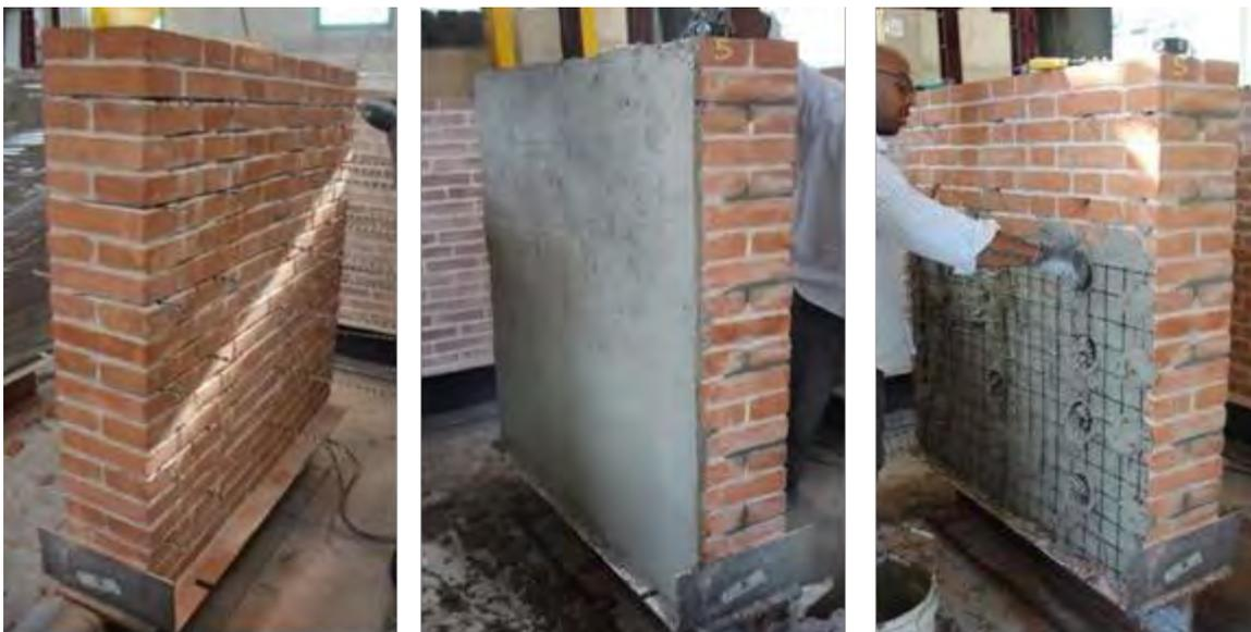
**Figura 88:** Fasi di applicazione del rinforzo per il pannello CD\_3, lato A e lato B.
