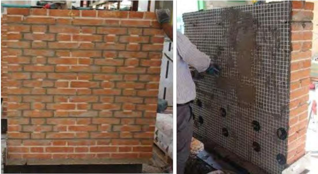
**Figura 87:** Fasi di applicazione del rinforzo per il pannello CD\_2, lato A (sinistra) lato B (destra).
